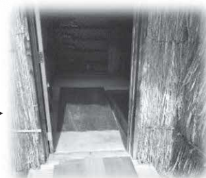
内部の段差にも スロープが設置された→
