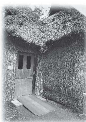
← 出入り口の段差に スロープが設置された チセ（アイヌの住居）
