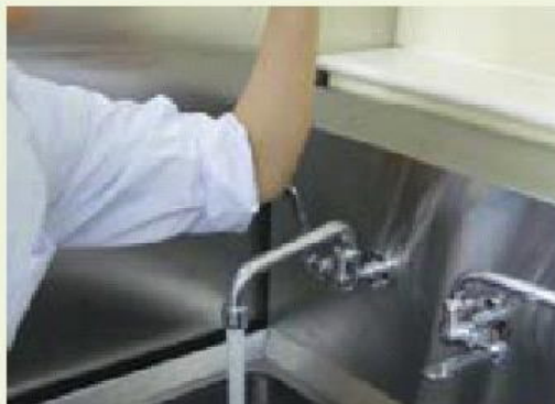
○ 肘で操作できるレバー式給水栓
