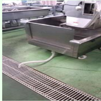
シンクの排水管から排水溝までパイプをつなぐ
