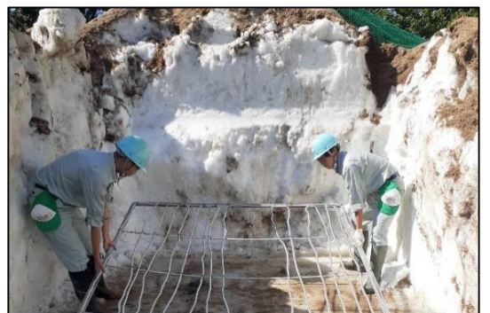
【雪山内に製作したフレキパイプを埋設】
