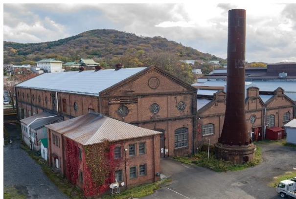
【旧火力発電所(日本製鋼所)：室蘭市】
