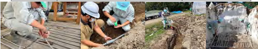
【図】冷却パイプ制作の様子
