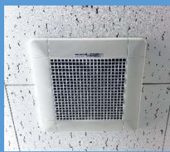
天井設置の換気扇
