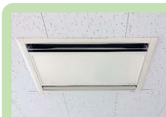
天井設置の熱交換換気
