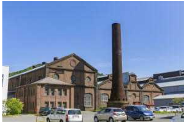
【旧火力発電所（日本製鋼所）：室蘭市】
