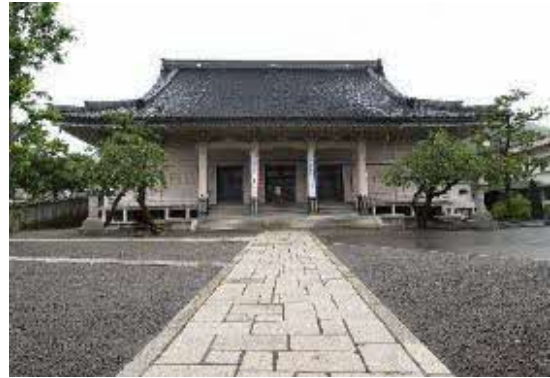
重要文化財「大谷派本願寺函館別院本堂」 (函館市)
