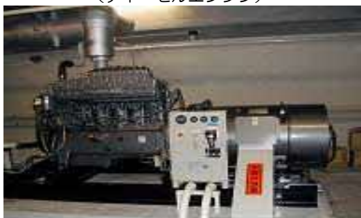
屋外用キュービクル式発電装置の例 (ディーゼルエンジン)
