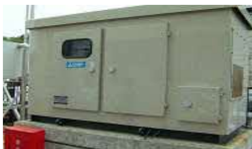
屋外用キュービクル式発電装置の例 (ディーゼルエンジン)
