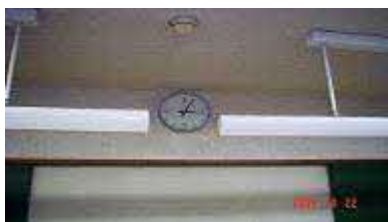
電気時計の例 （待合室に設置）
