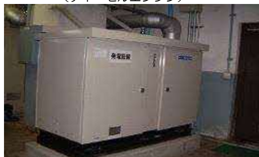
屋内用キュービクル式発電装置の例 (ガスタービン)
