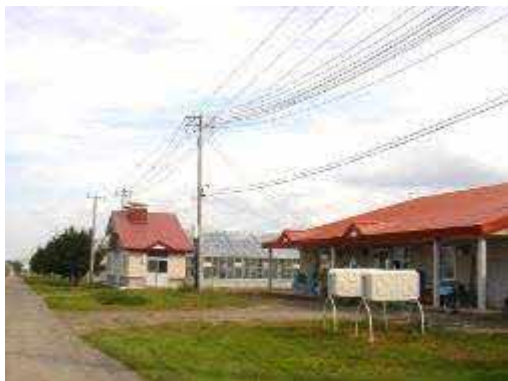
架空電線路の例
