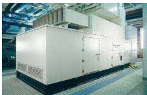
屋内用キュービクル式発電装置の例 (ガスタービン)
