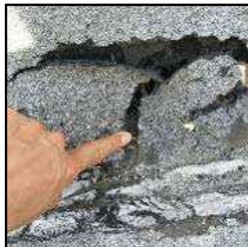
(防水シートの破れ)
