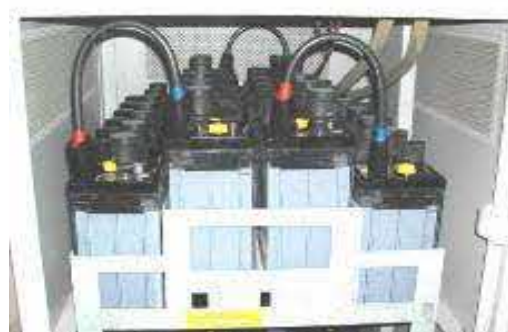
蓄電池種別 鉛蓄電池 HS-100E(触媒柱式 ※ 外形高率放電用 ※ -ト式据置鉛蓄電池)
