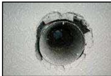
参考 (シーリングを撤去した状況)
