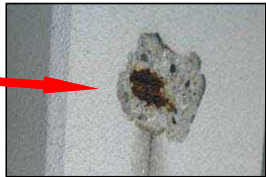
外壁仕上げ材(モルタル) 異常有り (ポップアウト部に鉄筋の露出)
