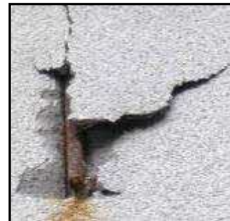
外壁仕上げ材(モルタル) 異常有り (ポップアウト部に鉄筋の露出)
