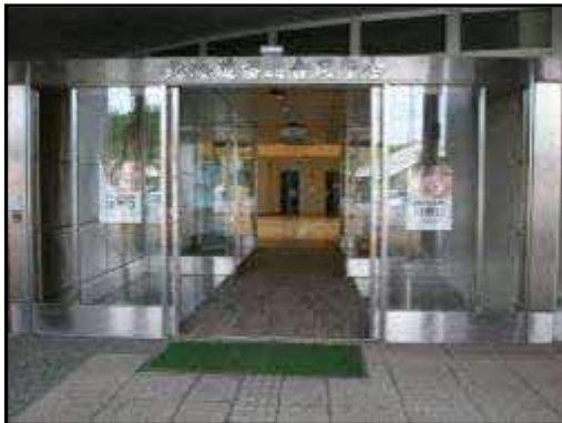
外部建具（自動ドア） 正常
