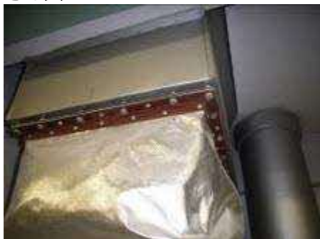
ダクトとキャンパス継ぎ手の接続部
