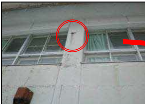
外壁仕上げ材(モルタル) 異常有り (ポップアウトの周囲に浮きが多数有る)
