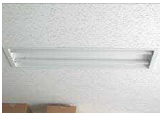
照明器具 異常なし
