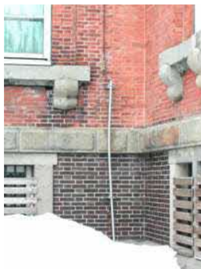
避雷導線 異常なし
