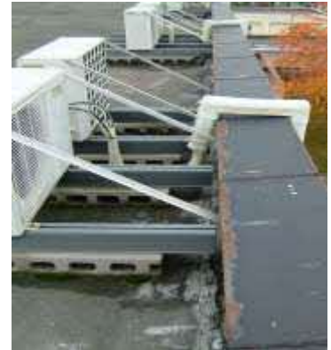
異常なし(耐震金物有り)
