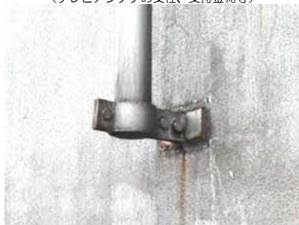
テレビ共同受信設備 （テレビアンテナの支柱、支持金物等）
