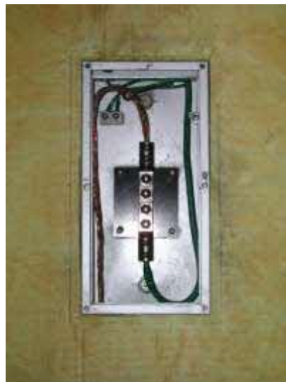
接地用端子箱内部 異常なし
