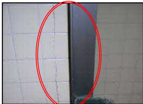
内壁 異常有り (モルタルの浮き、クラックが見られる)
