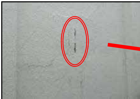
外壁仕上げ材(モルタル) 異常有り (ポップアウトの周囲に浮きが多数有る)
