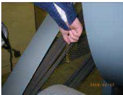
ファンベルトの張り具合点検状況
