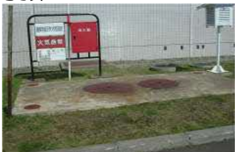
オイルタンク上スラブ、消火器・看板設置状況
