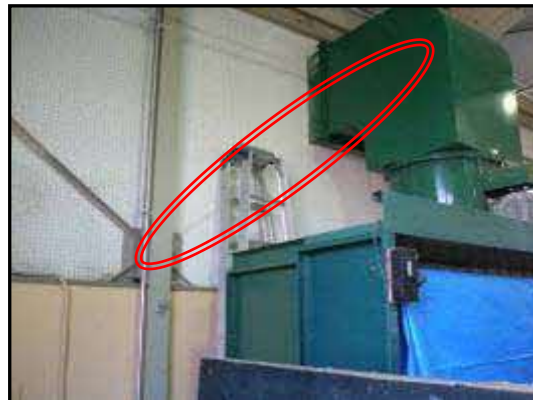
躯体(鉄骨造) 異常有り (鉄骨筋交いの撤去)
