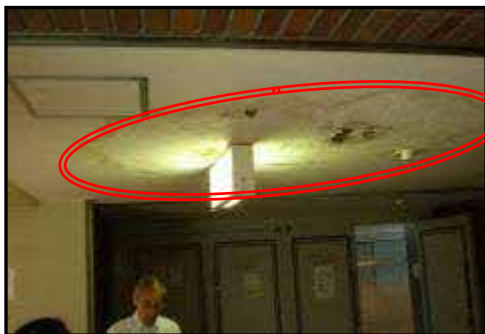
天井・内壁(仕上げ材) 異常有り (イキパツヨソツ・ゾヨイト金物のゆがみ)(タイルの割れ)
