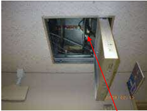
天井点検口からみたFD
