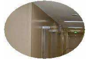
スチールパーティション内壁
