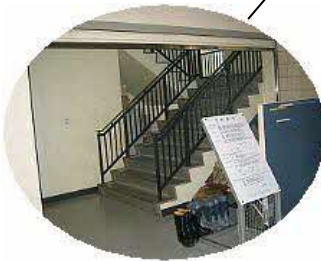
屋内階段と防火シャッター
