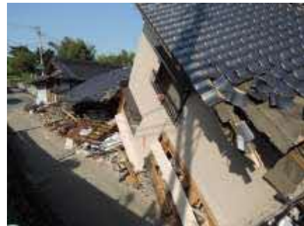
「平成28年(2016年)熊本地震」による建物の被害
