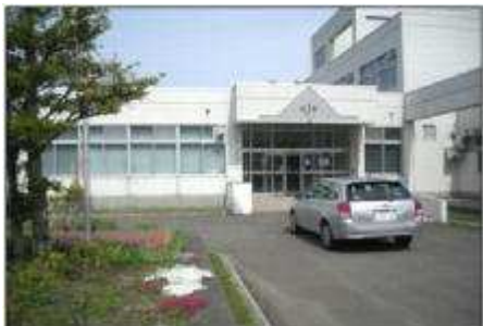
校舎棟(正面玄関)
