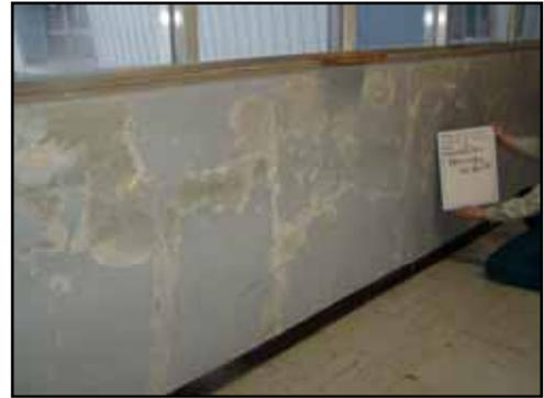
写真4 ひび割れの発生及び漏水跡例 [ T 値:0.9 ]
