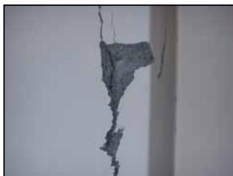
写真2 仕上材の剥落例 [T 値:0.9]
