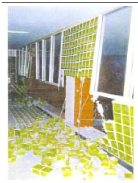
天井仕上材、断熱材が落下したものの。
