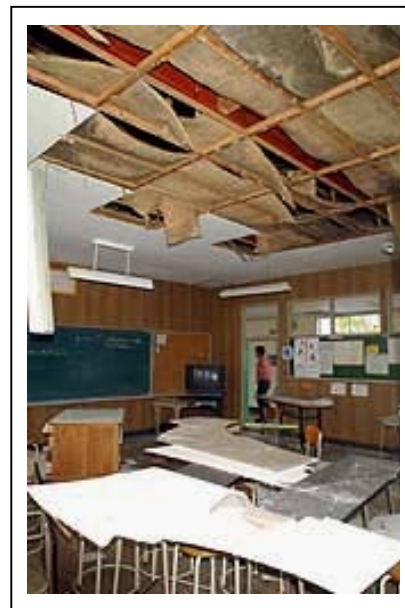
天井仕上材、断熱材が落下したものの。
