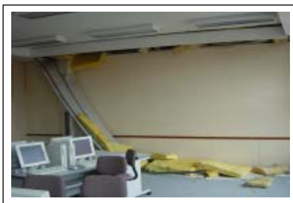
天井仕上材、断熱材が落下したものの。
