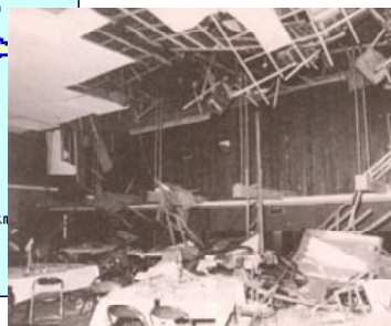
図3-22 浦河町福祉センター天井の落下〔浦河町〕
