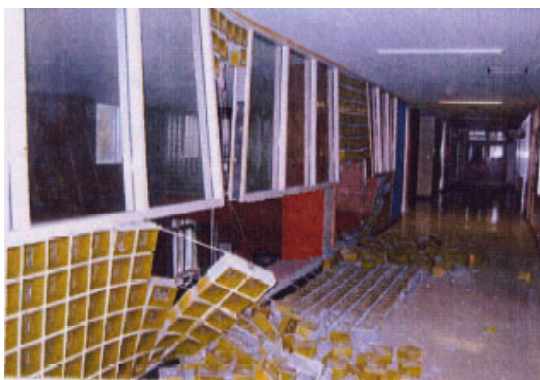
破損したガラスブロック
