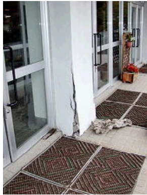
亀裂が入った玄関の柱
