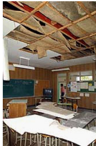
天井がほとんど剥がれ落ちた教室
