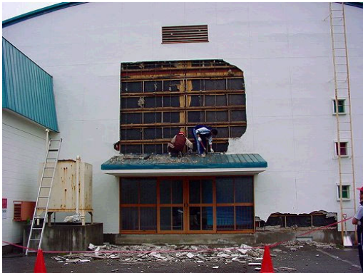
外壁が剥がれ落ちた体育館
