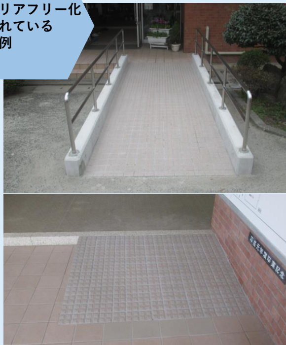
①昇降口の段差 を解消した
