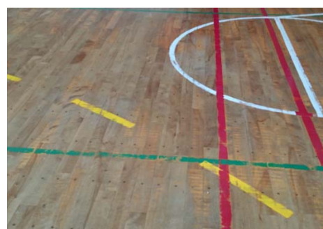
写真2 ラインの欠け
