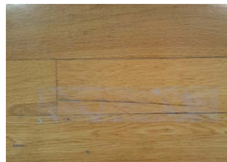
写真3 床板の割れをテープで補修
