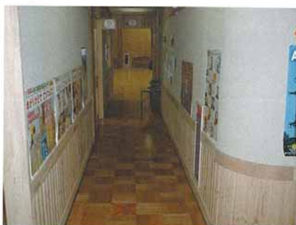
廊下（床・腰壁）
