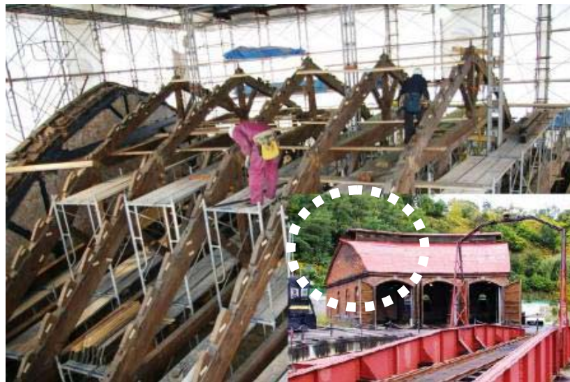
旧手宮鉄道施設 手宮機関車庫三号(小樽市) 屋根を解体調査しています。
