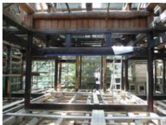
上國寺本堂の修理工事
