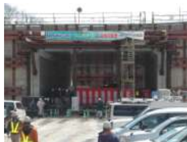
「鷲ノ木トンネル」の工事・完成
