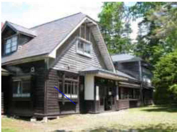
駅舎建物の現状 （道指定有形文化財「奥行臼駅通」）
