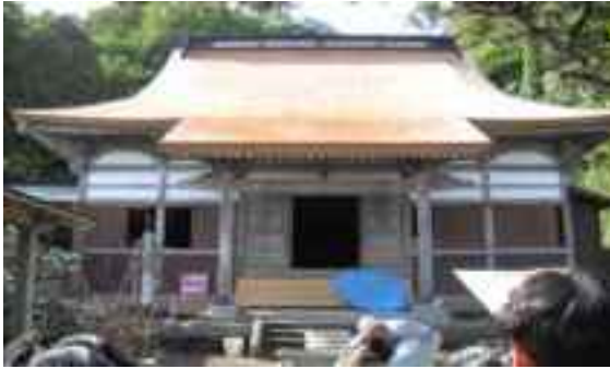
建物外観（屋根工事終了後）
