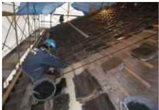
屋根工事（瓦葺き替え）
