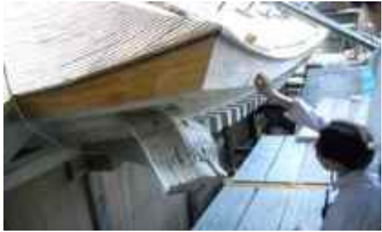
屋根工事（こけら葺き完了）
