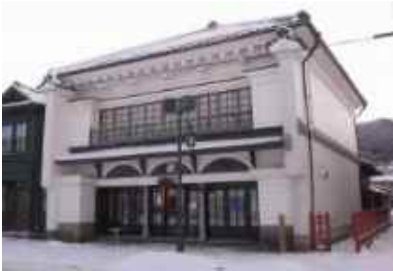
建物外観（工事完了後）
