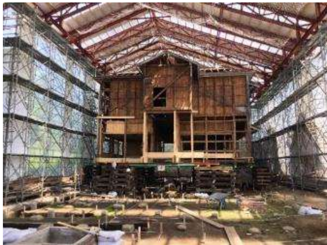
○奥行白駅通所主屋の保存修理と基礎部分の発掘調査
