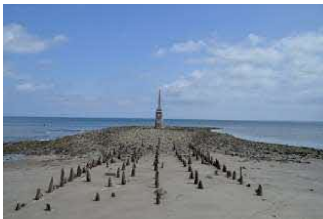
森町森棧橋跡 調査地近景
