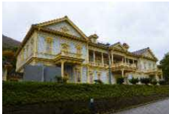
重要文化財「旧函館区公会堂」（函館市）
