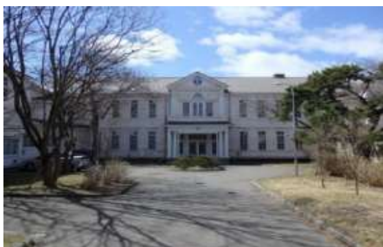
重要文化財「遺愛学院（旧遺愛女学校）本館」（函館市）
