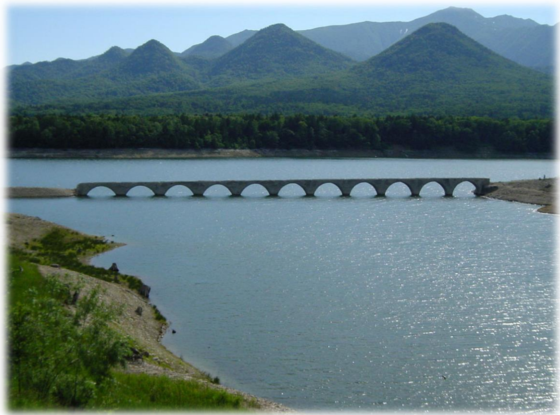
タウシュベツ川橋梁
