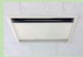
天井設置の熱交換換気
