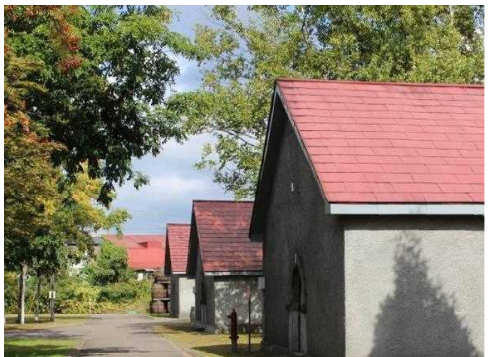
〔敷地内に並ぶ、ウイスキーを熟成させるための貯蔵庫〕
