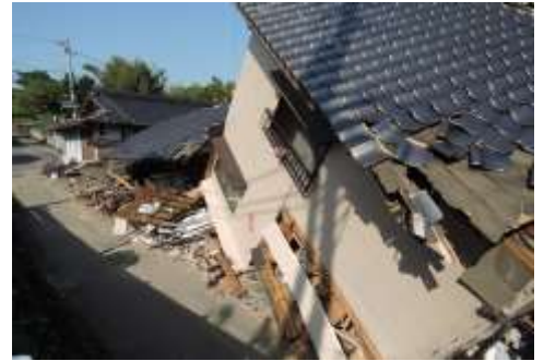
「平成28年(2016年)熊本地震」による建物の被害
