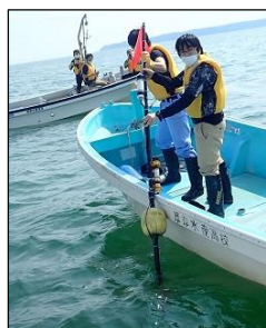
スマートブイの設置作業
