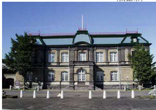
重要文化財「日本郵船株式会社小樽支店」 (小樽市)
