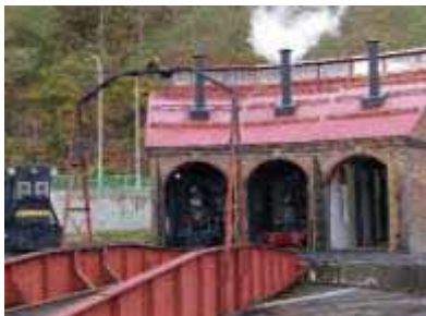
「本館・機関車庫」
