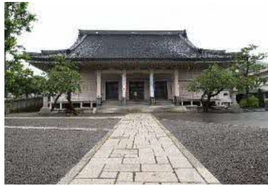
重要文化財「大谷派本願寺函館別院本堂」 (函館市)
