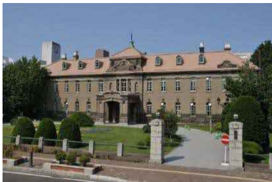
「旧札幌控訴院庁舎」(札幌市)
