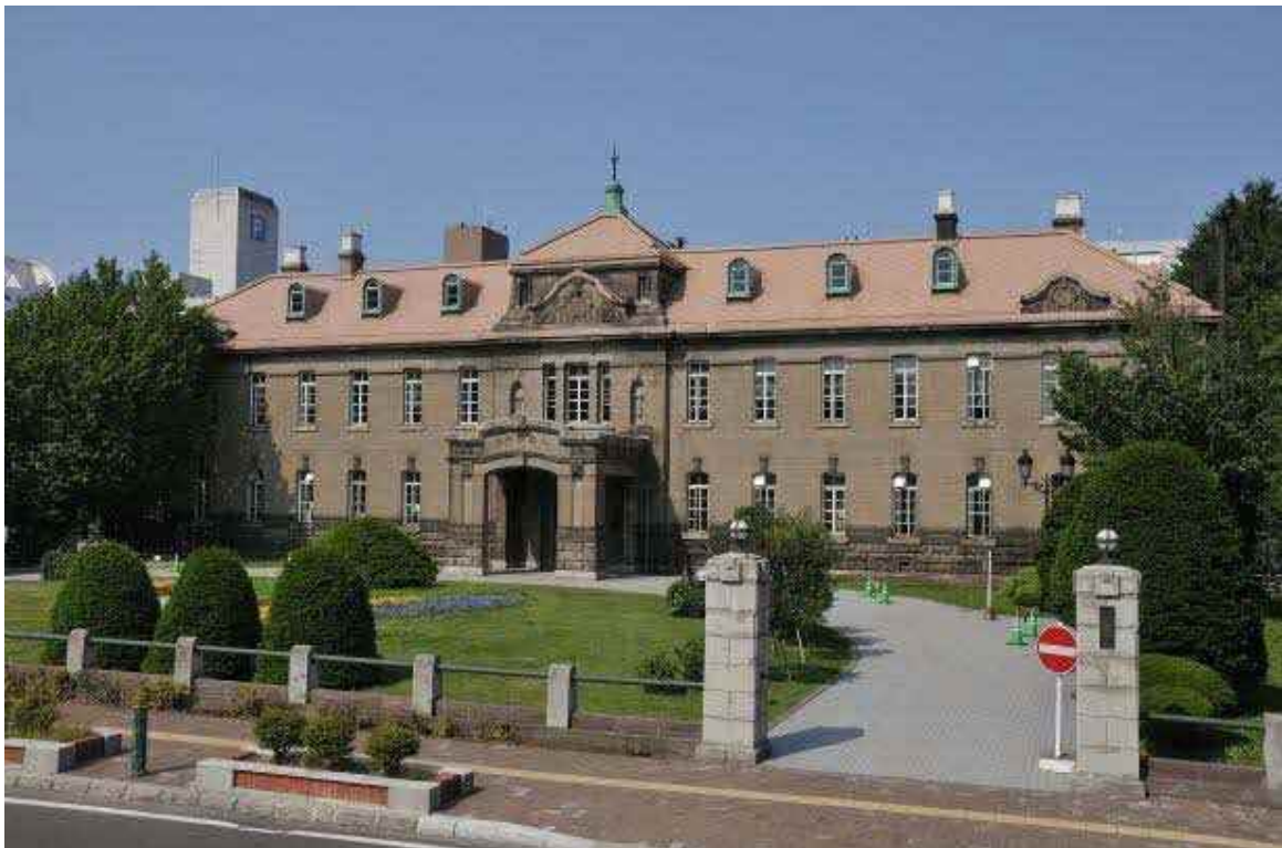
旧札幌控訴院庁舎全景
